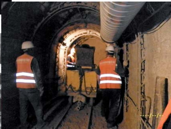
Obr. 4 Podzemní práce v pískovcovém podloží (foto I. Kaki)
