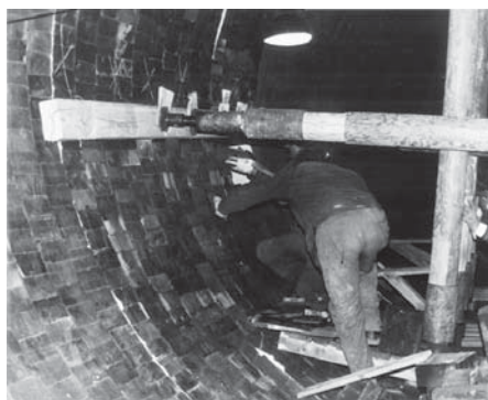
Obr. 3 Vyzdívání šamotovými cihlami
